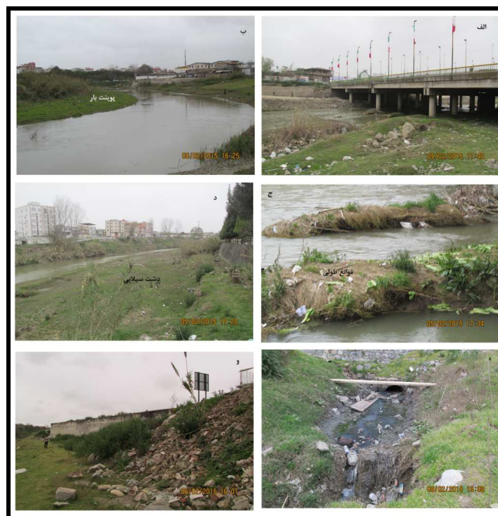
شکل ۲: تصاویر بابل رود، الف) رسوبگذاری در پایه پل، ب) پیوننت بار، ج) موانع طولی درون کانالی، د) دشت سیلابی، ه) پرشدگی کالورت، و) تخلیه نخاله شهری و کاهش عرض رود
